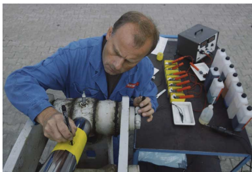
Abb. 4: Wichtig ist die genaue Kennzeichnung der Schadensstelle und ein sorgfältiges langsames Arbeiten
